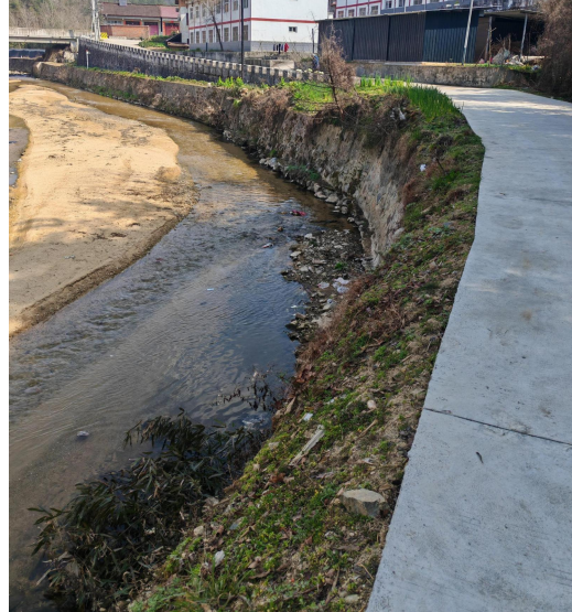
左河村村委会段现状河道
